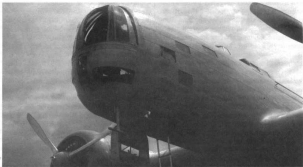
Ранний ДБ-3 с моторами М-85, переделанный в учебный в мастерских АОН-1, на испытаниях в НИИ ВВС, июнь 1938 г.
